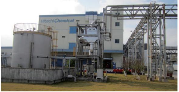
引进溶剂回收装置
