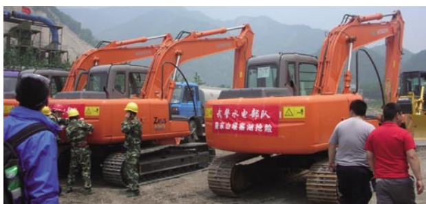
在灾区重建中表现活跃の日立建机的挖掘机
