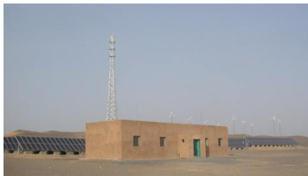
甘肃省雅丹地貌风景区的电气室以及 风力发电（100kW）、太阳能发电（100kW）设备
